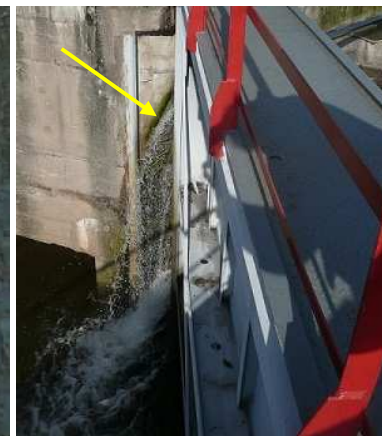
Obr.10 průsak pravá vrátně
