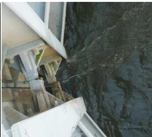
Obr.9 Průsak na srazu vrátní
