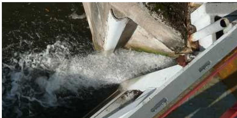
Obr. 12 Průsak na bočním těsnění pravá vrátně
